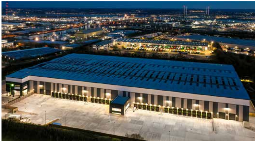
Purfleet Commercial Park（英国 | グレーターロンドン）
