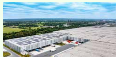
グッドマンで世界最大の太陽光発電施設 ドイツ、マール
